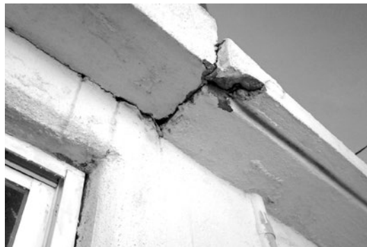
Vivienda cuarteada en la colonia 16 de Septiembre, El Tepeyac, municipio de Malinaltepec. Julio 2016. Foto. Lenin Ocampo.
