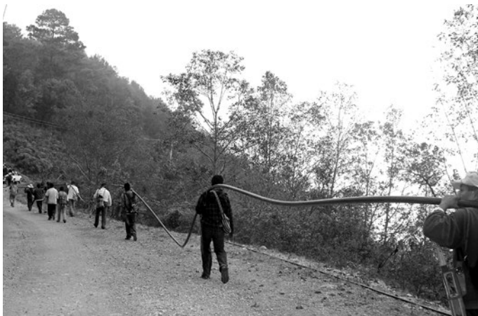
Comunidades reconstruyen sus sistemas de agua potable. San Miguel del Progreso. Enero de 2014.
