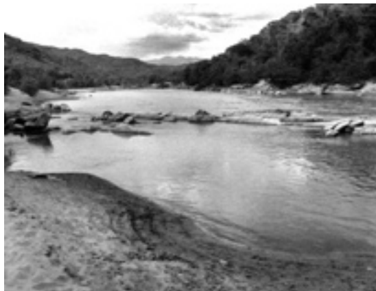
Panorámica del Río Papagayo en la zona de los cerros de Los Mayos y la Hierba Buena, donde se planea construir la cortina de la presa. [Fotografía · Tlachinollan]
