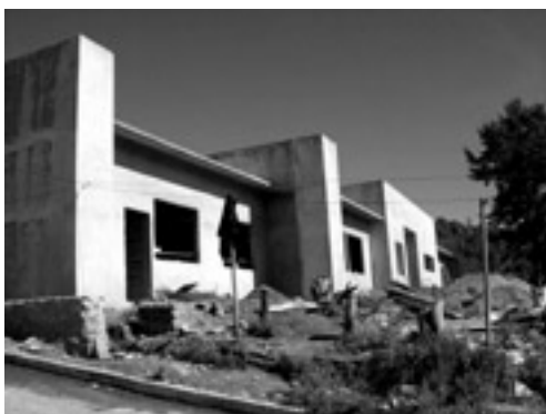
Construcción del nuevo Centro de Salud de Metlatónoc que vendrá a sustituir a los vagones de tren. Se espera que se concluya la obra en el 2009. Foto: TLACHINOLLAN
