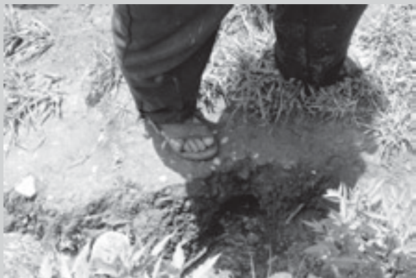
Comunidad de Zaragoza tras el agrietamiento de sus tierras.
