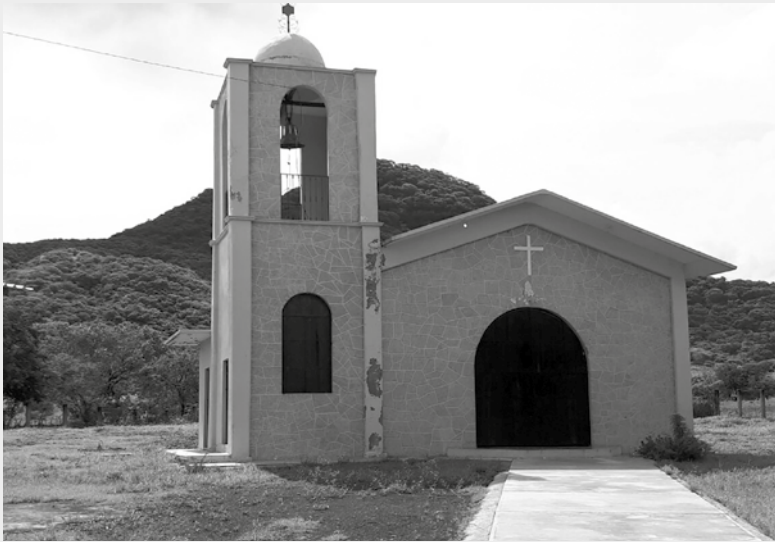
Capilla de La Gavia, Municipio de San Miguel Totolapan, Guerrero, julio de 2017. Foto: Sergio Ocampo
